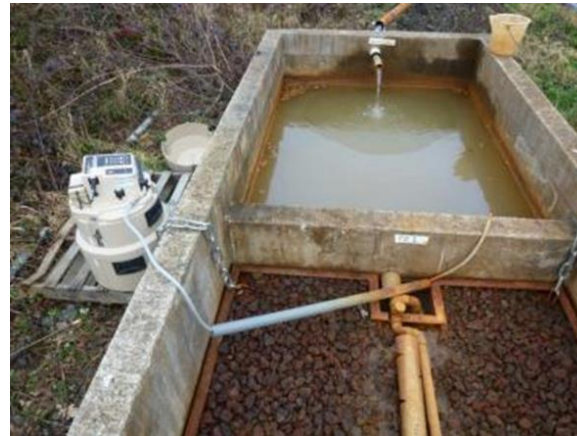
Pilote sur site
