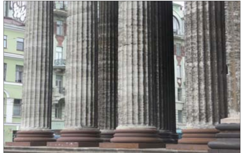
Илл. 24. Пудосткий камень в наружных колоннах южного портика не имеет чёрной корки. Фото А.Г. Булаха. 12 августа 2011 г.
