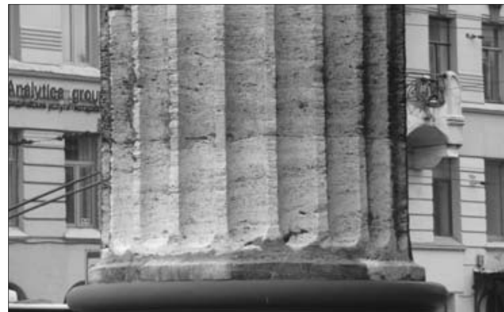
Рис. 19. Во всех блоках пудостского камня по всей высоте колонн слоистость ориентирована горизонтально (отмытая дождём колонна в юго-восточной части южного портика собора). Фото А.Г. Булаха. 9 сентября 2011 г.
