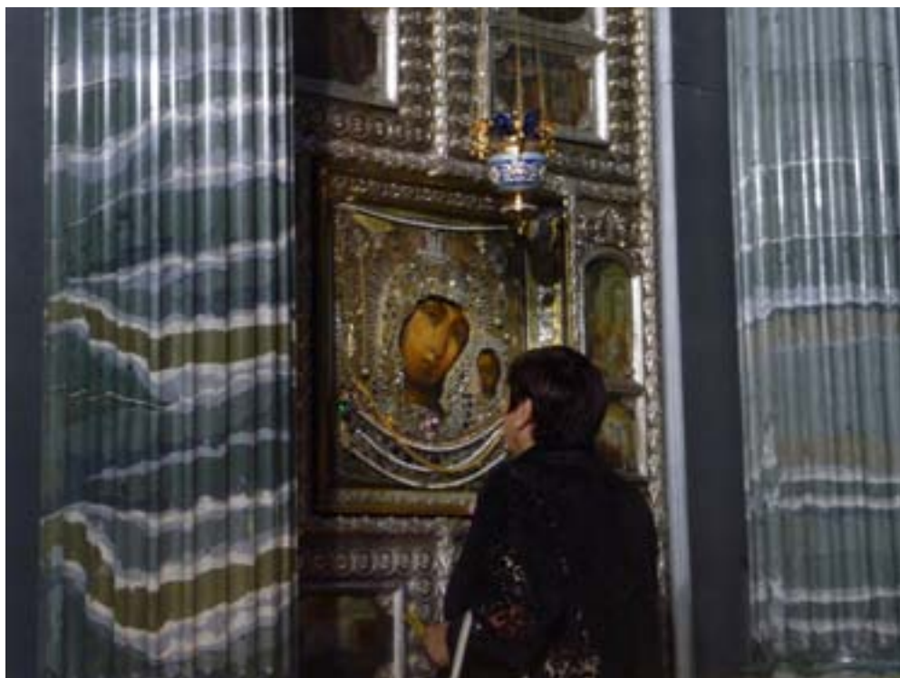
Илл. 13. Прокрашенные под вид ревнёвской яшмы колонны из искусственного камня (стюка) в иконостасе Казанского собора. Фото А. Г. Булаха. 2 сентября 2012 г.
