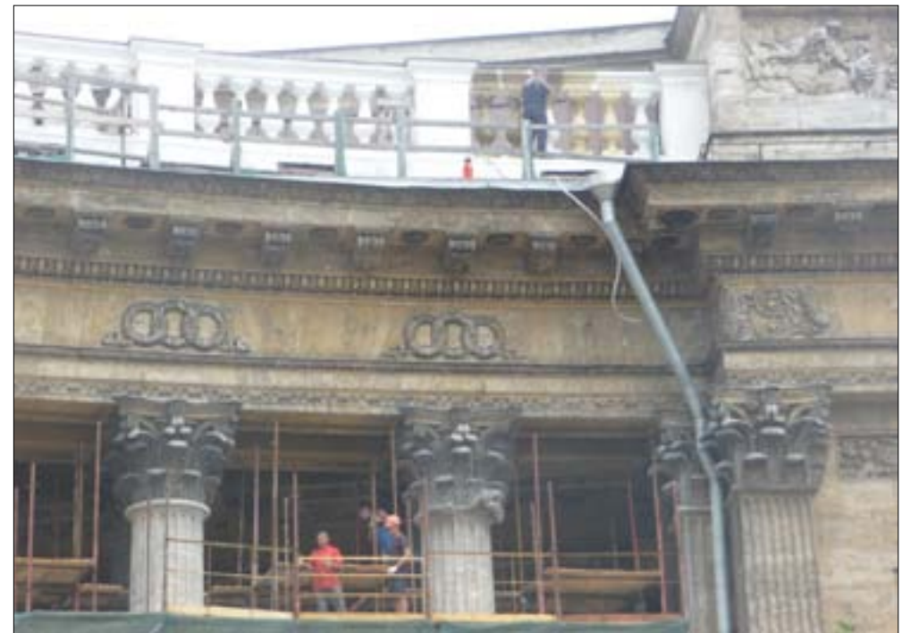
Илл. 19. Рабочий момент. Видны две очищенные колонны, нечищенный камень, малярный окрас балюстрады и естественно чистый (промытый дождём) аттик собора. Фото А. Г. Булаха. 15 июля 2011 г.
