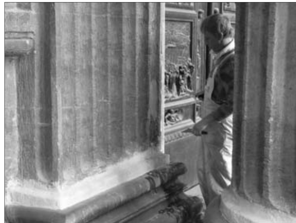
Рис. 46. Рабочий момент. Мастиковка дефектов камня. Фото А. Г. Булаха. 8 сентября 2011 г.
