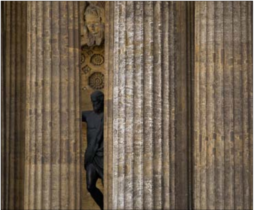
Илл. 1. Пудостский камень в оформлении стены собора и ниши со скульптурой святого князя Владимира. Видна природная слоистость камня, заметны многочисленные реставрационные вставки середины 1960-х годов
