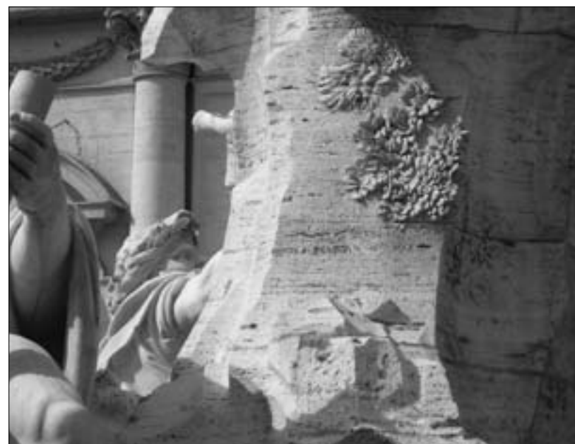
Рис. 2. Рим. Травертин в художественном оформлении Фонтана Рек. Хорошо видна природная пористость камня. Фото А.Г. Булаха. 2012 г.
