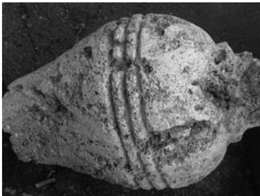
Рис. 45. Разрушенная балясина из балюстрады (хозяйственный двор у собора). Фото А. Г. Булаха. 9 ноября 2011 г.
