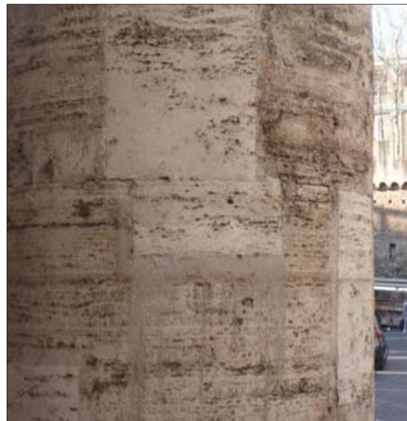
Илл. 28. Собор св. Петра в Риме. Вставки — следы прежних реставраций и грязный травертин. Фото А.Г. Булаха. 16 марта 2012 г.
