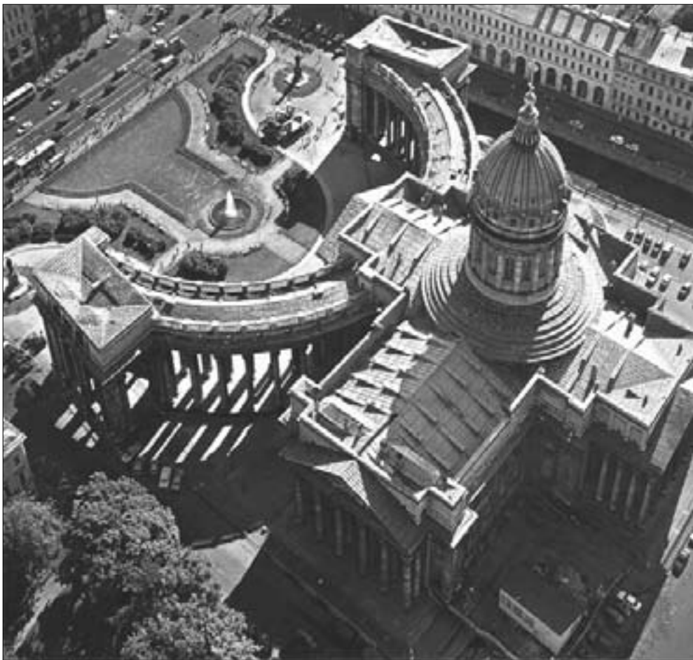
Рис. 8. Казанский собор в Петербурге. Вид в необычном ракурсе даёт возможность оценить пропорции здания и дуговых колоннад, устройство крыш и их парапетов, барабана и купола собора
