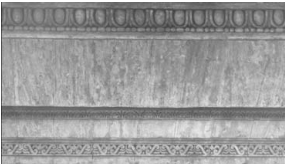
Рис. 17. Во фризе плиты пудостского камня развёрнуты так, что естественная слоистость камня почти вертикальна и зеркально отражается в соседних плитах. Фото А. Г. Булаха. 2010 г.
