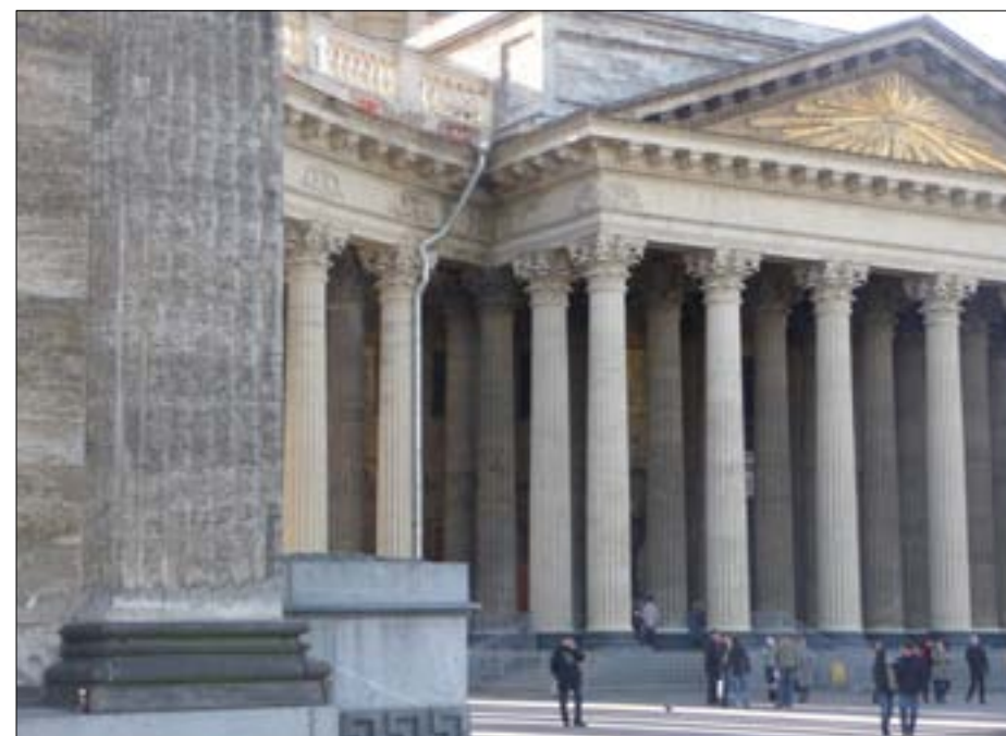
Илл. 22 а, б. Части фасада с «накрывкой» и без неё. Врезки вербковского туфа и заделки пудостского камня. Фото А. Г. Булаха. 12 августа 2011 г.
