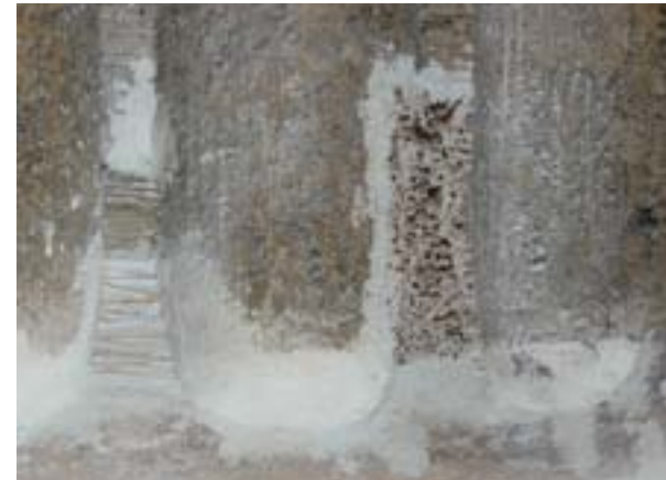
Илл. 18. Врезки вербовского туфа и заделки пудостского камня. Фото А. Г. Булаха. 12 августа 2011 г.
