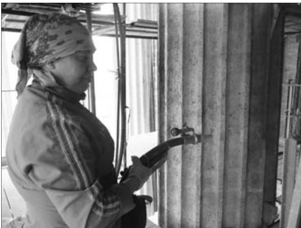
Рис. 47. Рабочий момент. Труба с регулятором и соплом, через которую выдувается абразивный порошок. Фото А.Г. Булаха. 2 сентября 2011 г.
