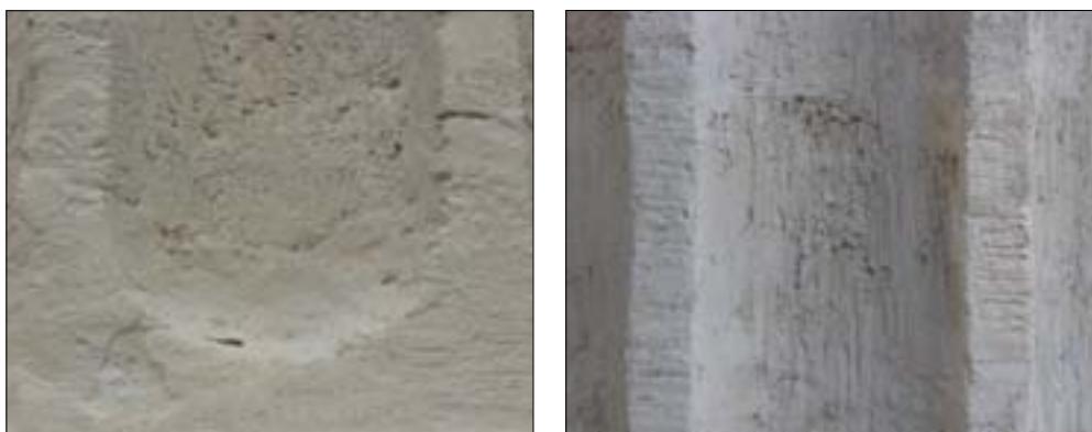
Илл. 20. Плотные слои известкового раствора скрыли под собой рисунок и фактуру природной поверхности пудостского камня. Фото А. Г. Булаха. 28 сентября 2011 г.
