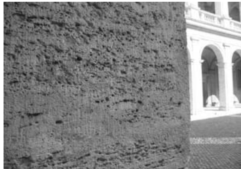
Рис. 3. Рим. Травертиновый пилон в церковном дворе. Видны слоистость и природная пористость камня. Фото А. Г. Булаха. 2012 г.
