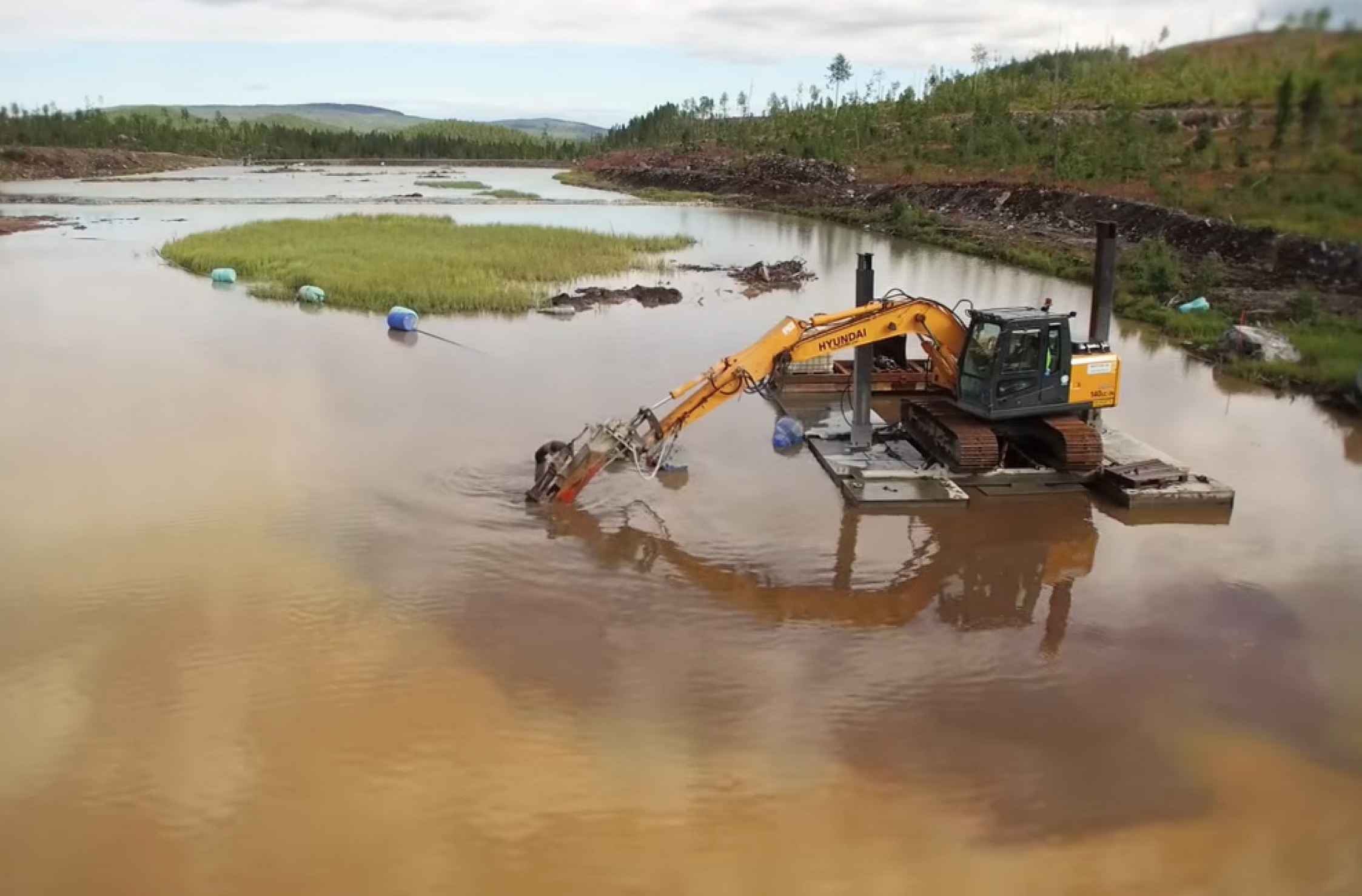
Rikastushiekka-altaan ruoppausta Svartträskgruv- anin kaivoksen alueella. Kuva: SGU
