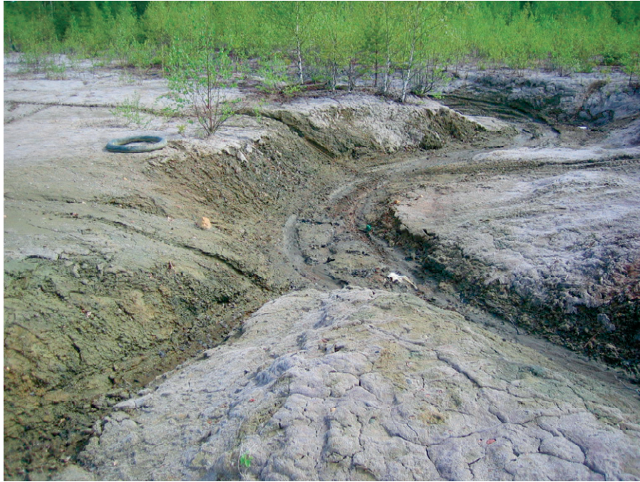
Kuva 30. Haverin kupari-kulta-kaivoksen rikastushiekka-alue Viljakkalan kirkonkylässä. Sadevesi ja lumen sulamisvesi valuvat uomia pitkin ja kulkeutuvat rikkoutuneen padon läpi Kirkkojärveä kohti. Kuva Annika Parviainen.
