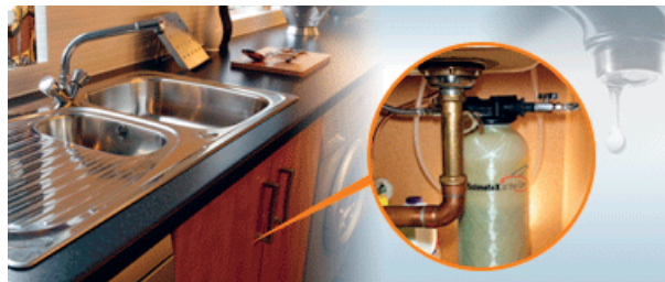
Kuva 52. Esimerkki käyttömukavuudesta: keittiön alakaappiin sopiva amerikkalainen suodatin, jolla käsitellään kaikki hanasta tuleva kylmä vesi ( http://www.npxtra.com/index.html ).
